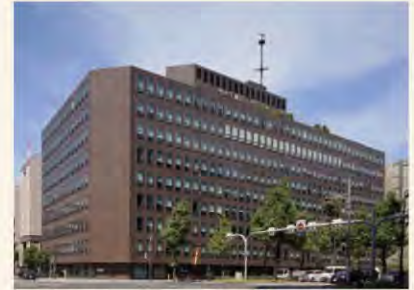
本社工屋(御堂ビル)昭和40年竣工
